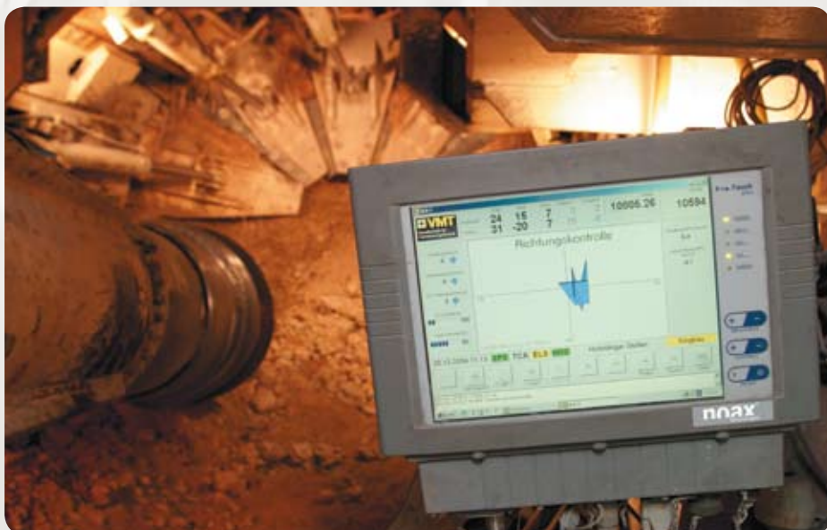
Der noax-IPC C12, direkt neben dem Fräskopf, liefert wichtige Informationen über den Tunnelvortrieb.
