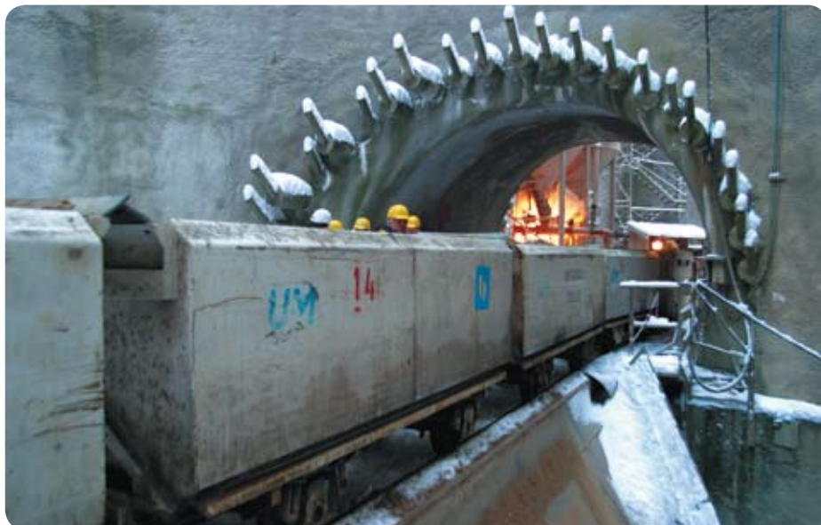
Eingang zu dem im Bau befindlichen Trinkwasserstollen am Hofolding Forst, 20 km südlich von München.
